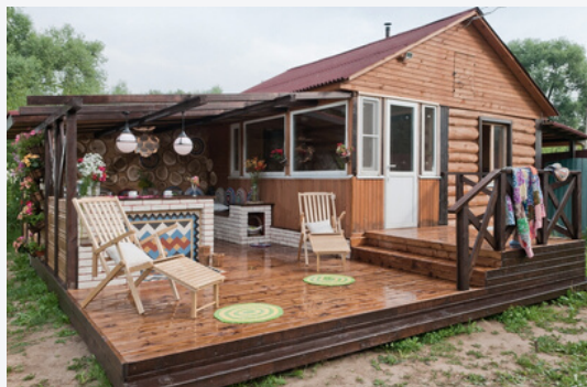
Строительство домов и дач (в т.ч. каркасное)
